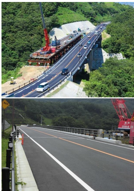
高知丸高が俵山大橋の仮棧橋を施工(ネットから引用)
