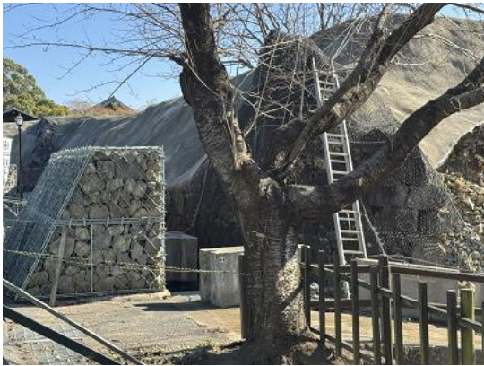
復旧工事中の石垣
