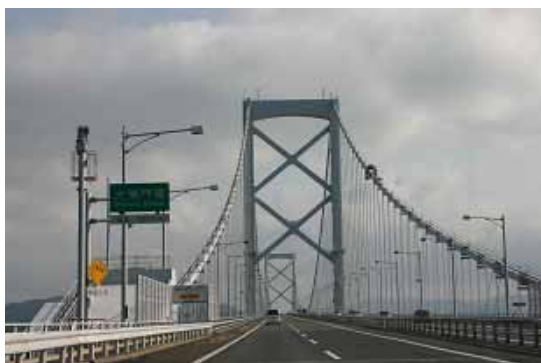
強風で制限速度 40km の大鳴門大橋
