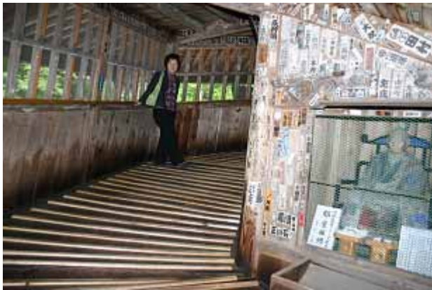
斜路になっているので階段がない
