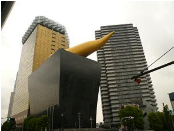
アサヒビール吾妻橋本部ビル
