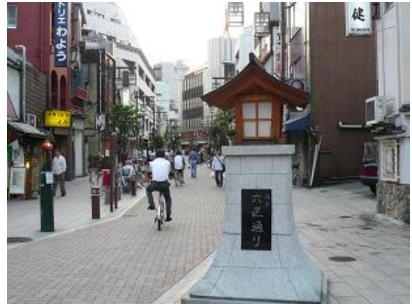
平成17年3月に完成した六区通り
