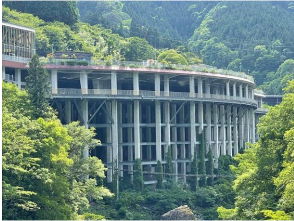
高知丸高が施工した基礎杭
