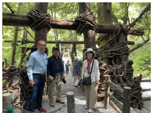
かずら橋の左岸主塔部。通行料は一人550円。
