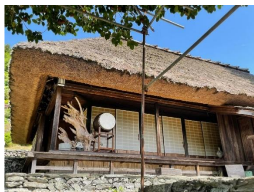
茅葺の古民家「木村家」
