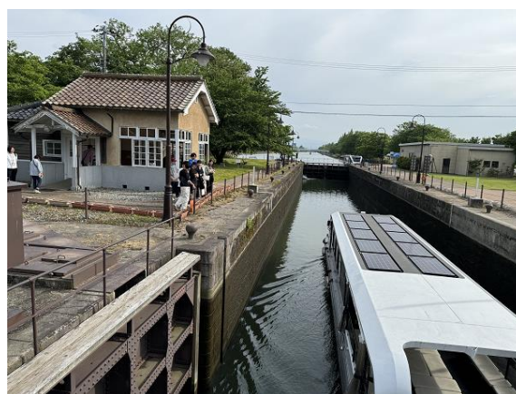
左側の小屋が閘門の操作室
