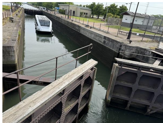
下流側から眺めた中島閘門
