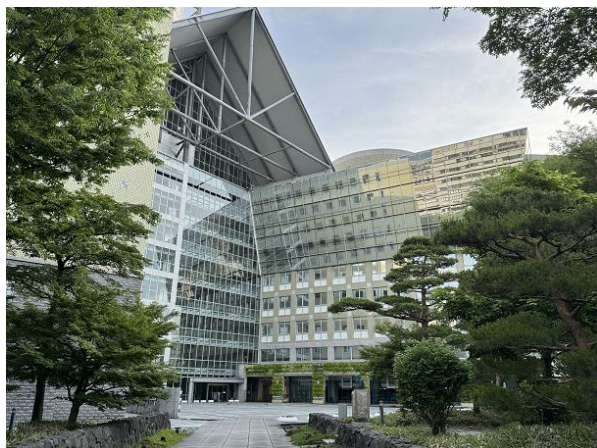
富山市役所の建物
