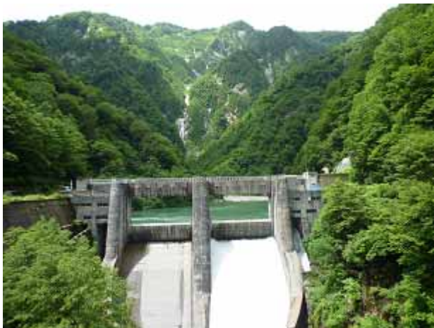
昭和 15 年に完成した仙人谷ダム。日本電力が黒部川水系で最後に建設した発電用ダム。土木学会の「日本の近代土木遺産 現存する重要な土木構造物 2000 選」に認定されている。
