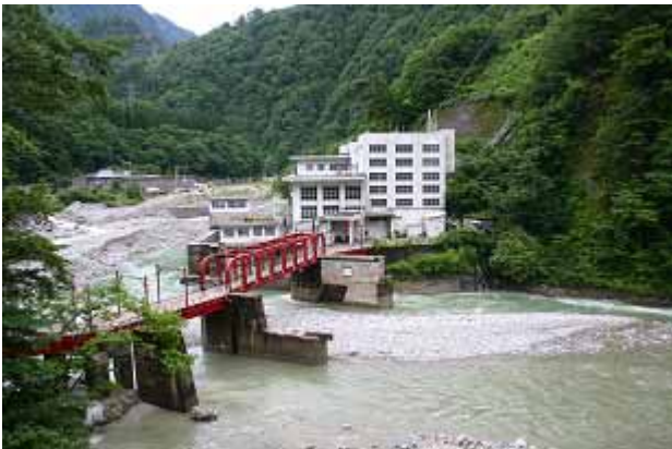
黒部川第二発電所
