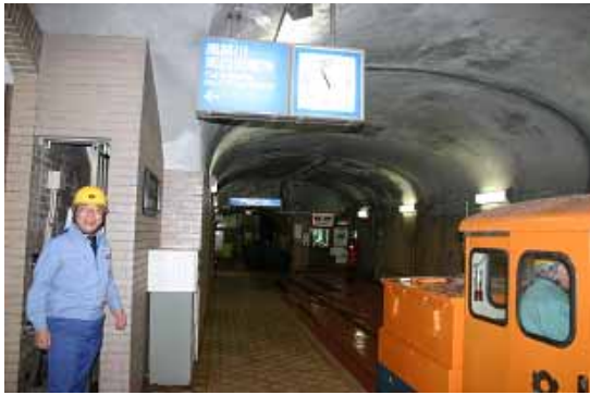
上部軌道の終点となる黒部川第四発電所前駅。 ここから黒部川第四発電所に入る。
