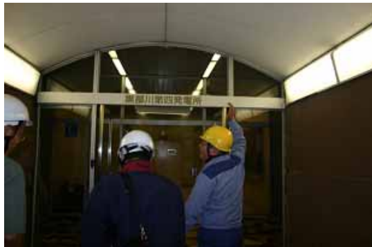
黒部川第四発電所の入り口
