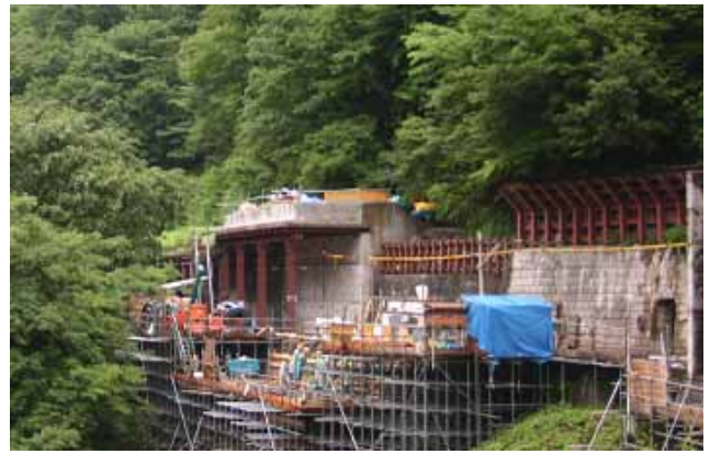
黒部溪谷鉄道を維持管理していくためには、雪崩防護工などの工事が必要なのだろうか。
