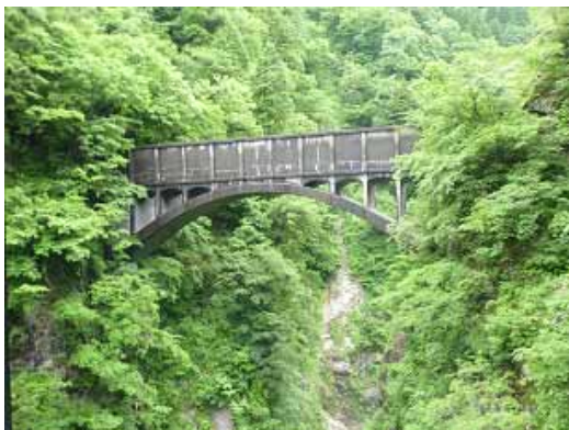
コンクリートアーチ橋
