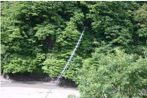
猿専用の吊橋。猿が実際に利用しているとの説明であった。
