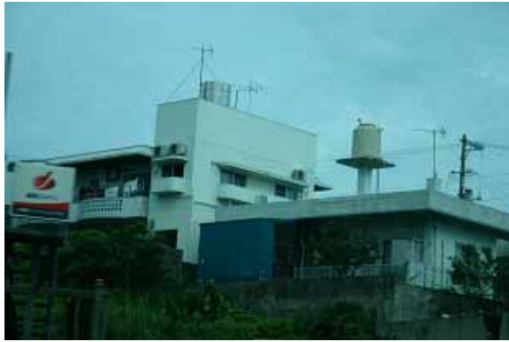
屋根の上の貯水タンク
