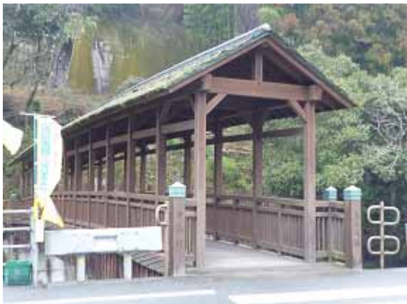
切妻で、屋根は杉皮葺き。一見すると木橋。
