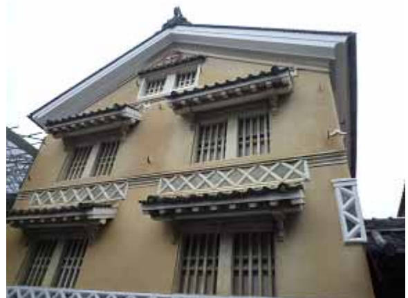
本芳我邸の土蔵。浅黄色の漆喰壁には、後々の修繕を考慮して足場を吊すためのL型の金具が取り付けられている。
