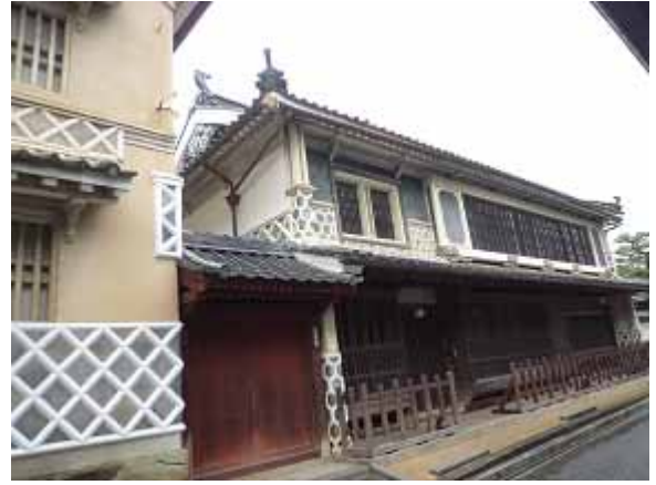
本芳我邸の母屋と左側が土蔵。土蔵の海鼠壁(なまこかべ)は、一般的な菱格子模様であるが、母屋の海鼠壁は珍しい亀甲模様となっている。
