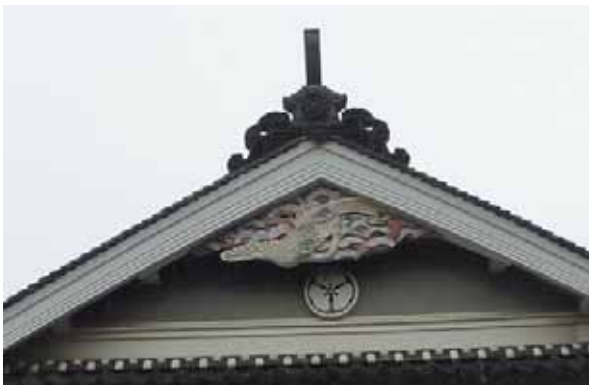
母屋の懸魚(げぎょ)。懸魚とは、屋根に取付けられた妻飾り。木造家屋を火災から守るため、水に縁のある魚の形をした飾りを屋根に懸けて火伏のまじないとしたのが始まりとされている。魚の身代わりを屋根に懸けることが「水をかける」という意味にも通じている。
