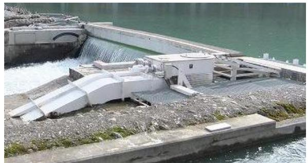
一ノ井堰の左岸側にはチェコ製のサイフォン式水車発電機が設置されており、流れ落ちる水の一部を利用して発電が行われている。
