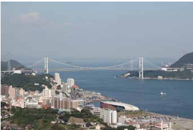
「海峡ゆめタワー」の展望室から眺めた関門大橋。
