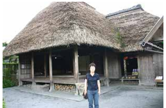
知覧型二ツ家。二つの屋根の間に小棟をおいて繋いだ知覧独特の建築様式。
