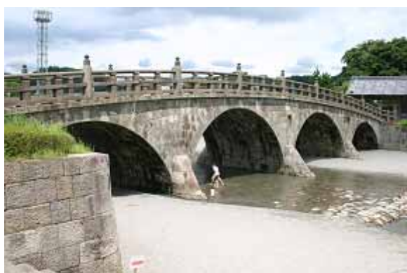
西田橋の下流側
