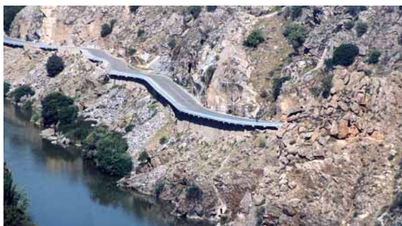
写真 51 急峻な地形につくられたレドの道路
