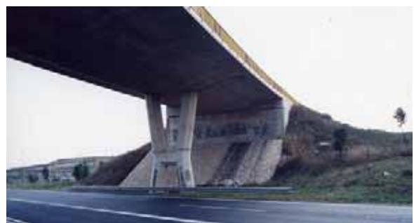
写真13 Landa Palace Hotel 近くの高架橋
