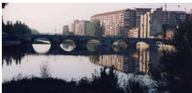
写真 23 サン・マルコス橋
