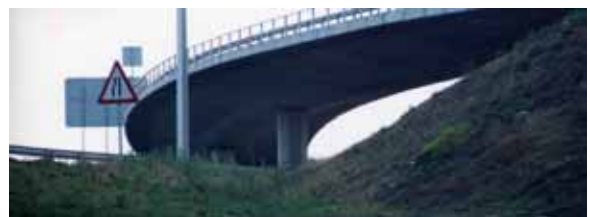
写真12 Landa Palace Hotel 近くの高架橋
