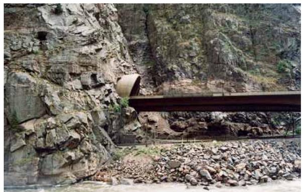
写真 8 ロックアンカーで補強されたトンネル抗口
