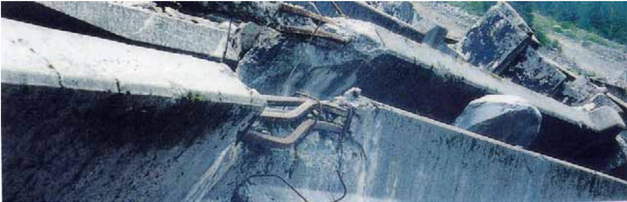
写真 22 廃棄されていた上部構造と四角い異形鉄筋
