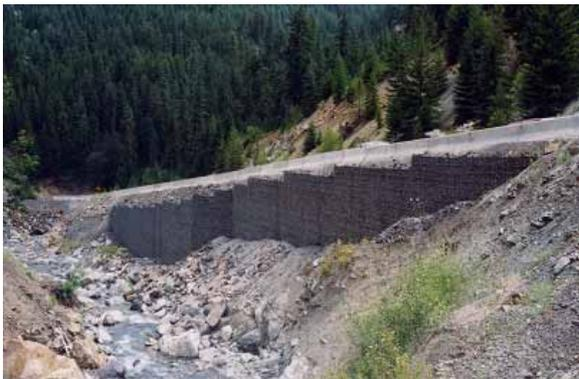
写真 24 途中で見かけたワイヤーフレーム補強土壁
