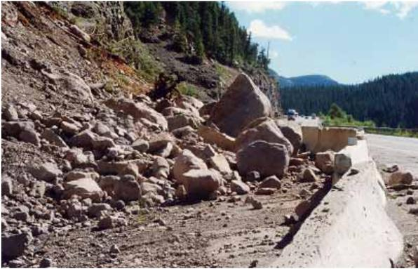
写真 18 U.S-160 号線の落石とコンクリートバリアー
