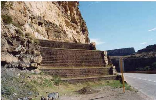
写真 11モジュラーブロックを用いた MSE-Wall 山留め壁
