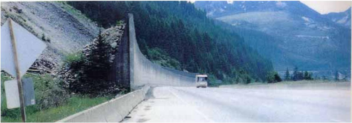
写真 21 上部工が撤去されたスノーシェッド
