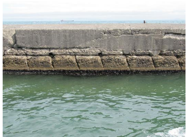
写真-11 北防波堤の斜塊ブロック
