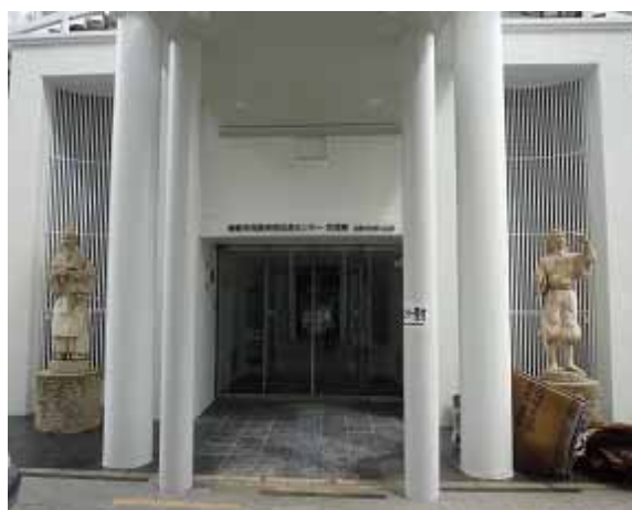
改修工事中の建物の入り口には、「倉敷市児島市民交流センター交流棟」と表示されている。
