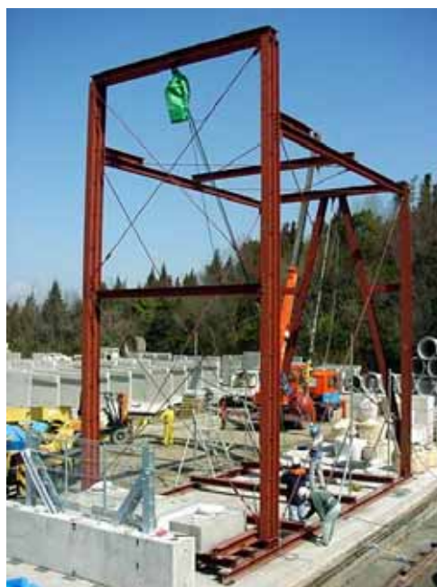
写真2 落石防護柵の重錘衝突実験 9)
