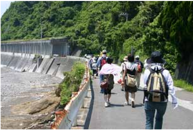
前方には日本サミコン製の PC ロックシェッドが見える
