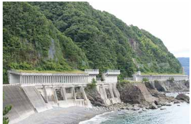
まるで落石対策工の見本市
