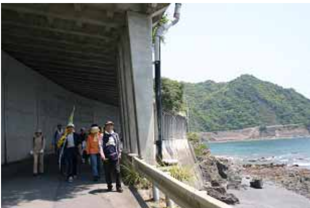
ロックシェッドの中は、落石の危険がない。
