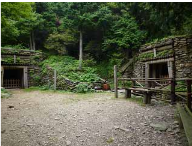
別子銅山発祥の記念すべき最初の坑道である歓喜坑と歓東坑。老朽化していたものを2001年に所有者である住友金属鉱山が開坑当時の状態に復元した。
