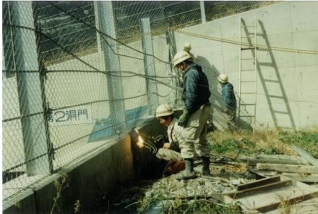
落石防護柵工の防護柵
