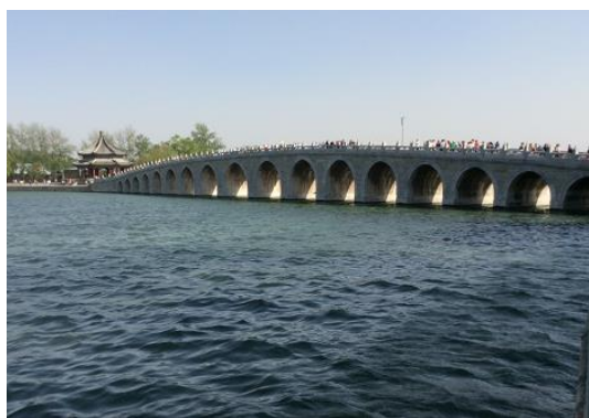
十七孔橋。昆明湖に架かった美しいコンクリートのアーチ橋。
