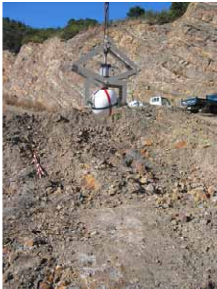
写真-1 コンクリート球と離脱装置
