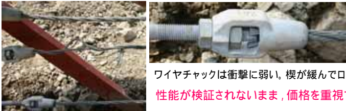
端末支柱のウェブが局部破壊 引付棒が破断 端末支柱と斜材の連結部の強度不足
