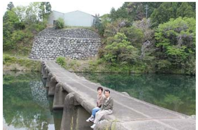
一斗俵(いっとひょう)沈下橋。橋長60.6m、幅員
