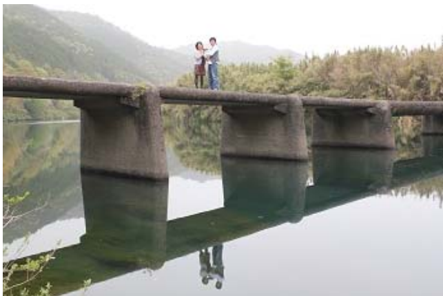
水面に映る一斗俵沈下橋
