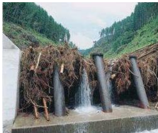
砂防堰堤の流木止め
