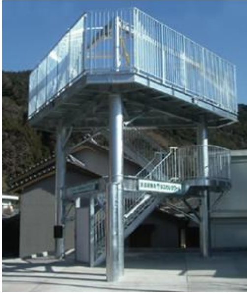
徳島県美波町津波避難タワー
