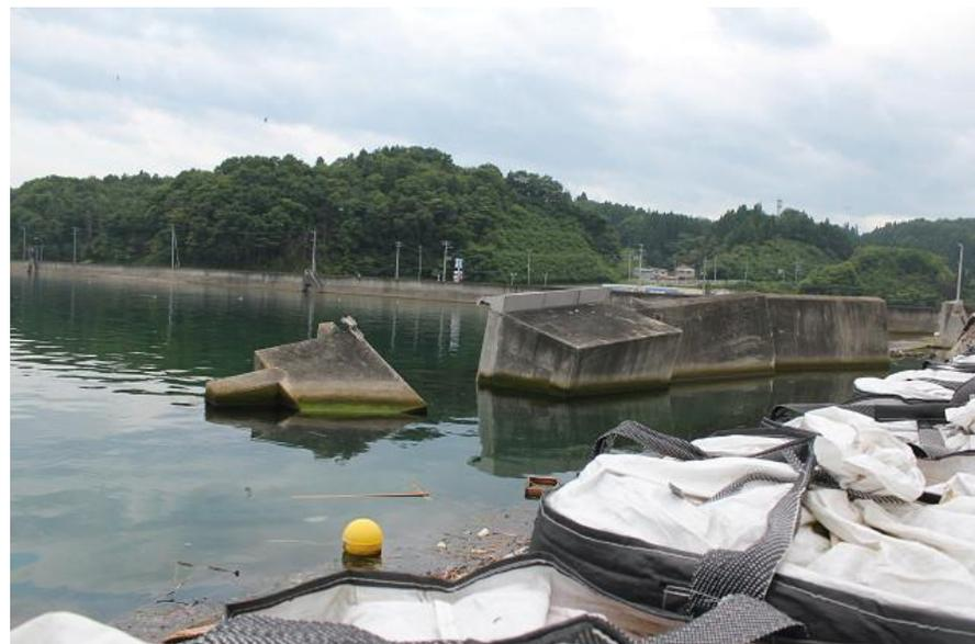
砂地盤が地震で液状化し、その後の津波で洗掘され、転倒
