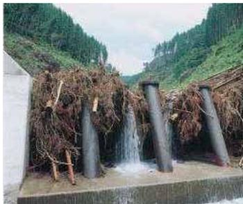
砂防堰堤の流木止め
