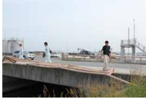
船舶が上流側の高欄を押し倒す
