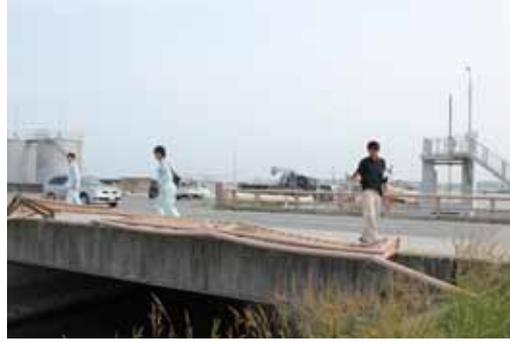
船舶が上流側の高欄を押し倒す
