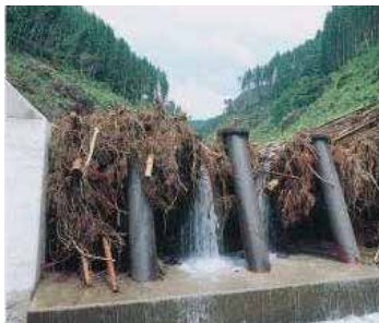
砂防堰堤の流木止め
