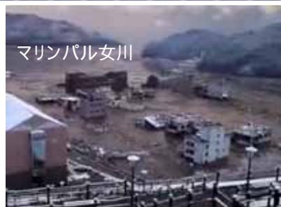
静水圧の13%の水圧で転倒
