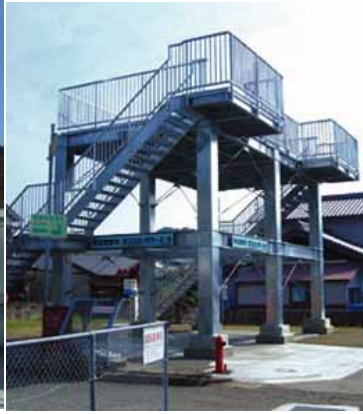
和歌山県串本町(6本柱)津波避難タワー
