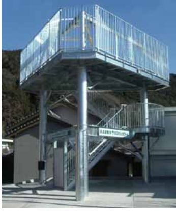
徳島県美波町津波避難タワー
