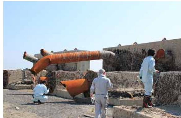
クレーン船で引き上げた西防波堤のブロック。鋼管杭が破断
