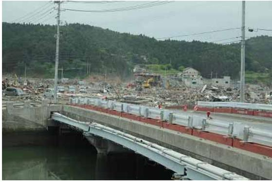
高欄は壊されても橋梁の損傷は軽微
