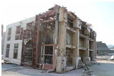
16 本のコンクリートパイル打設されていたビルも倒壊
