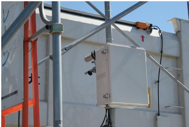
放射能を測定するセンサー
