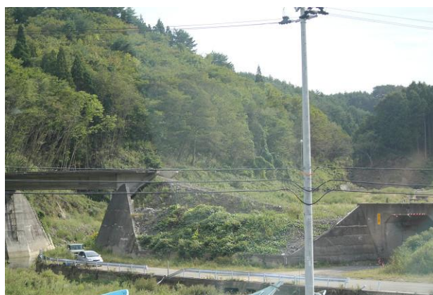
小泉大橋近くの JR 気仙沼線。コンクリートの橋梁は残っているが、盛土は津波で流失している。
