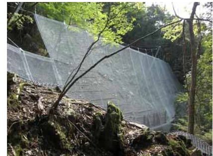
(e) 安倉林地荒廃防止工事(北川村)
