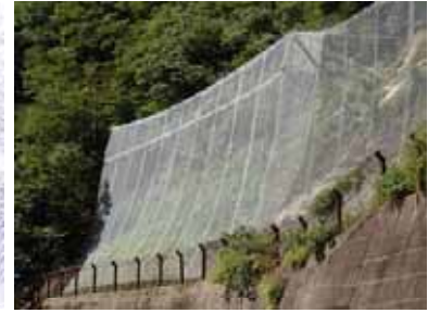
(b) 国道 195 号防災工事(香美市物部)
