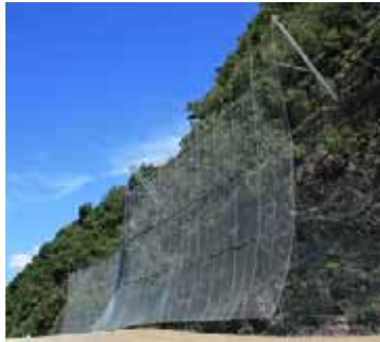
(c) 造成地のり面落石対策(須崎市)
