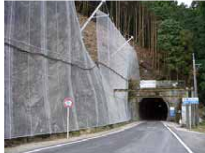
(d) 国道 319 号防災工事(四国中央市)
