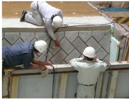
400gal加振後 擁壁がわずかに動く。間知ブロックの合端にわずかな亀裂
