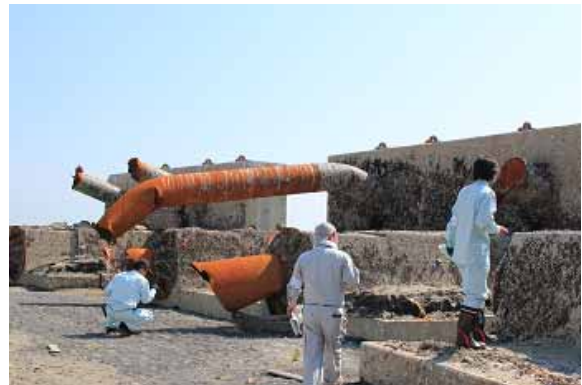
クレーン船で引き上げた西防波堤のブロック。鋼管杭が破断
