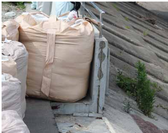
プレキャストコンクリート製の逆L型パラペット
