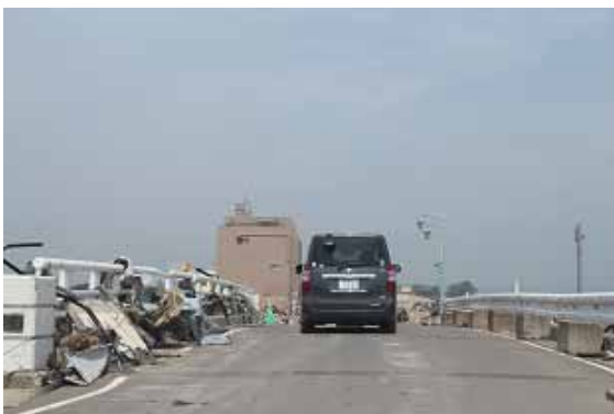
右側は仮設用防護柵であるが、左側の高欄は残っている。
