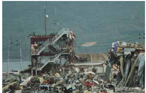
鉄骨だけになった防災対策庁舎
