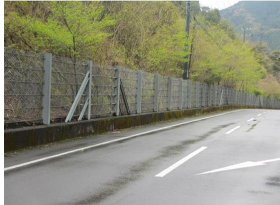
過去に私が設計した落石防護柵基礎。ケーソンのように根入れ地盤の横抵抗を考慮して設計してある。
